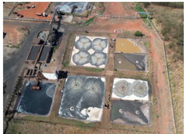
Estação de tratamento de esgoto (ETE).
